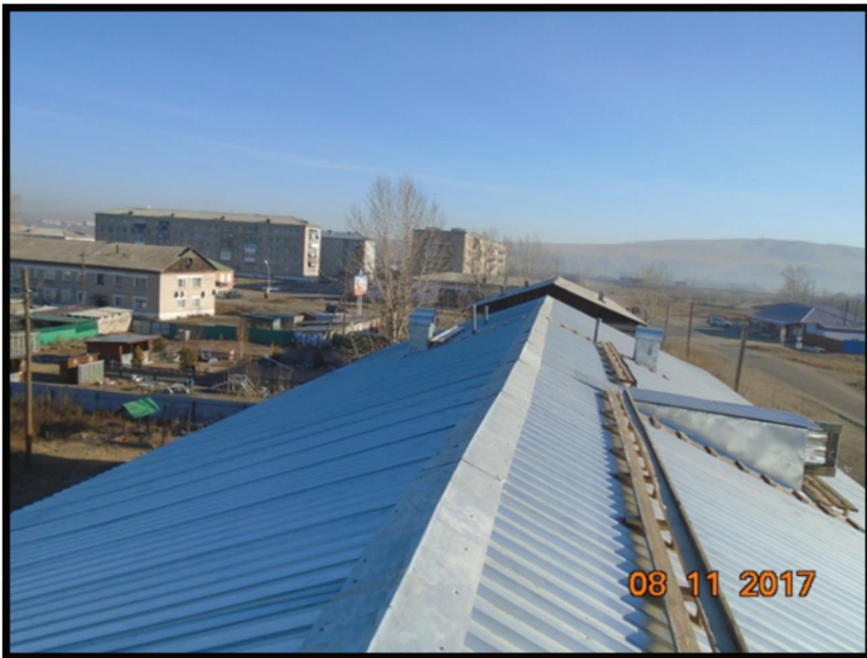
ПОСЛЕ выполнения работ
