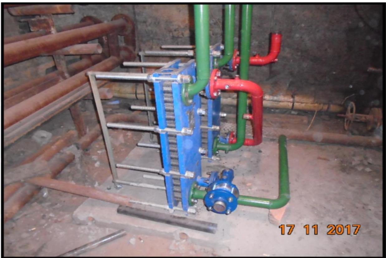
ПОСЛЕ выполнения работ
