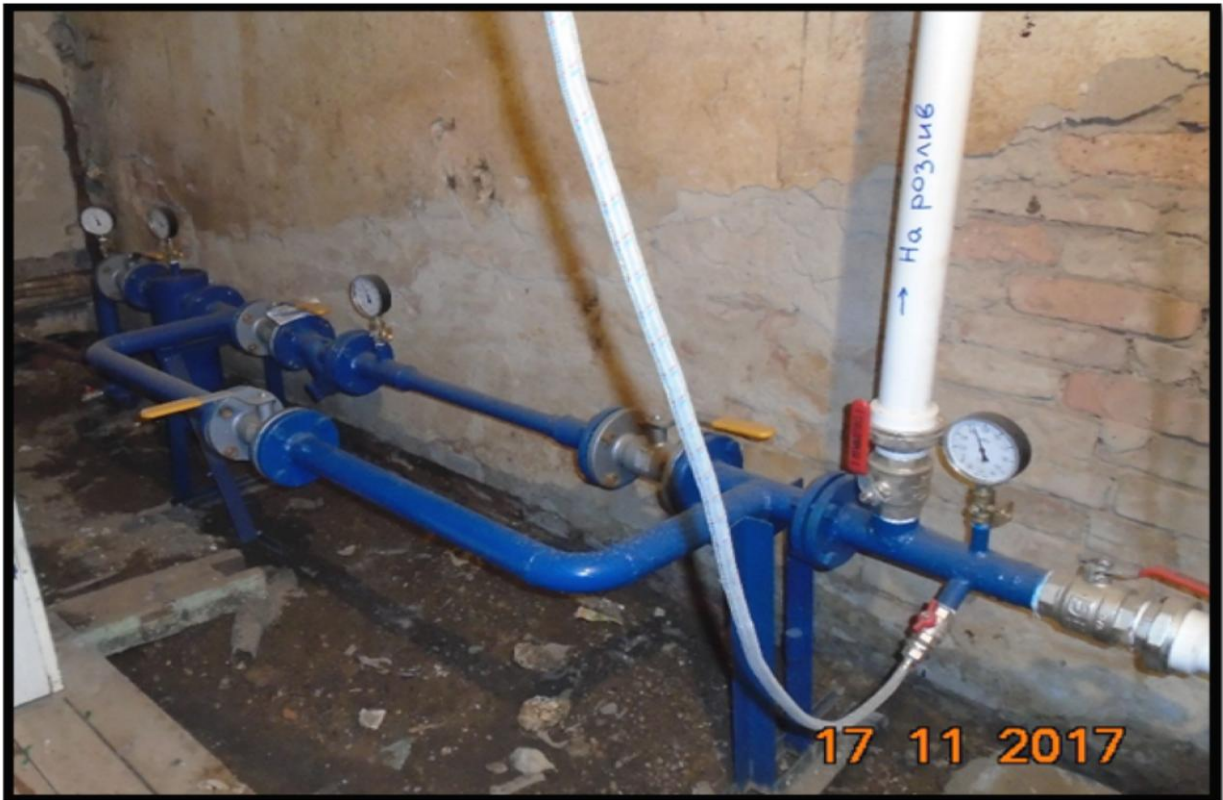
ПОСЛЕ выполнения работ
